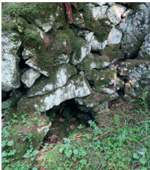
Abb. 113: Kalkbrennofen. Unten ist der Himmel, wo gefeuert wurde. Darüber sind Steine aufgeschichtet. Zusammen mit den Felbrocken bilden diese die Ofenrundung.
