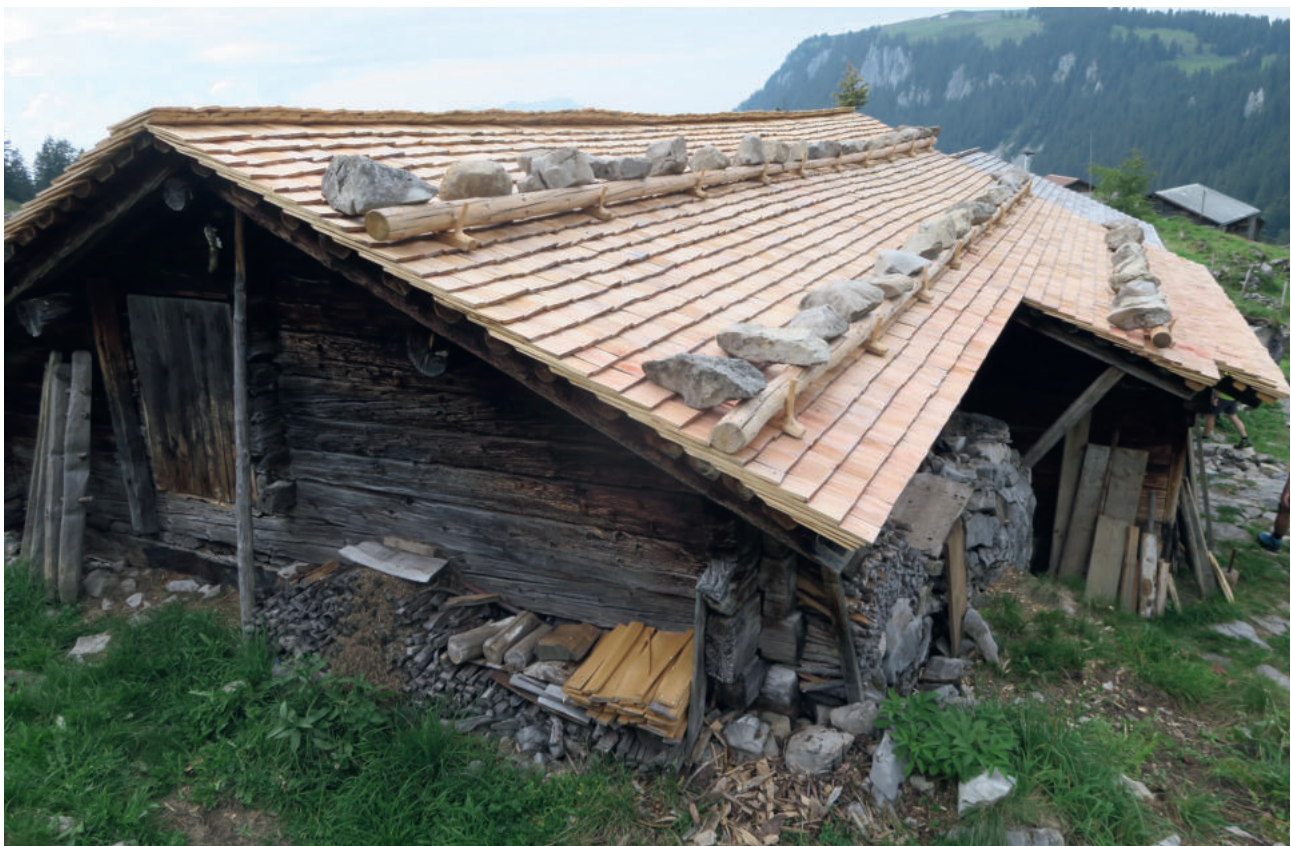
Abb. 106: Schindeldach
