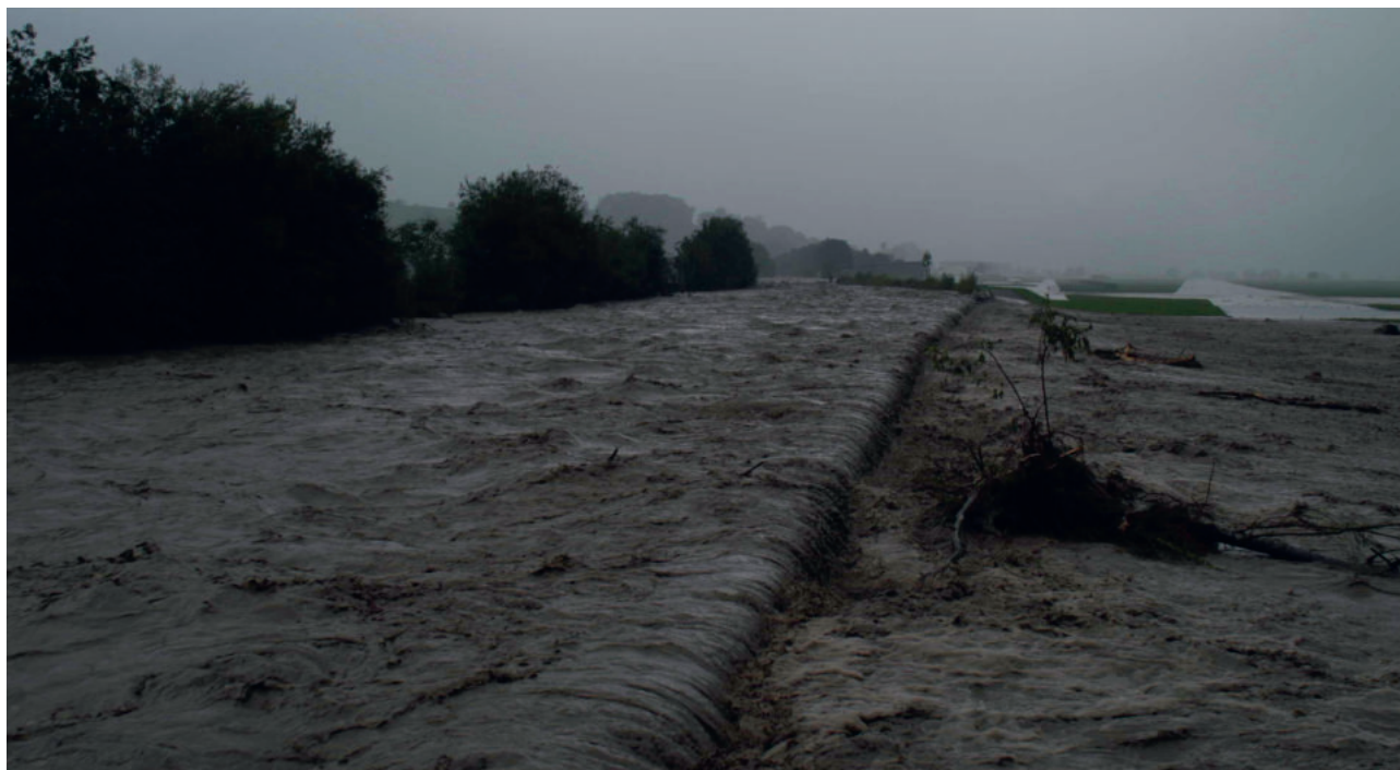
Abb. 121: Jahrhunderthochwasser. Buochs, 22.8.2005, Kippelemente im Einsatz
