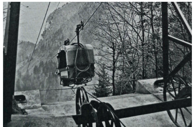
Abb. 12: Seilbahnfahrzeug mit unterliegendem Zugseil bei der Einfahrt in die Bergstation
